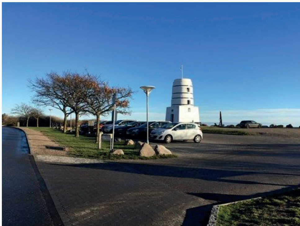
'Christiansø' med klinteovnen samt parkerings- og friarealer.
